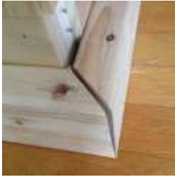
Poor Mitre Finish
